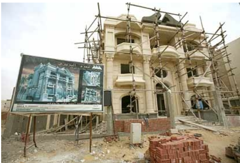
بنای مسکونی " گر انقیمت در حال اتمام در شهر 16 اکتبر قاهره
